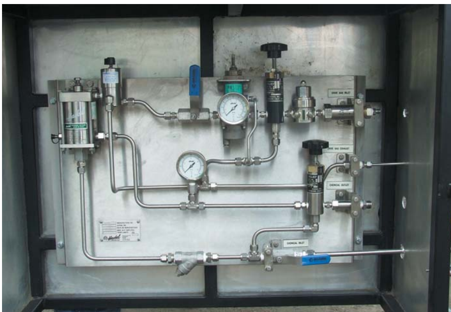
11. ábra. Csővezetéki vegyszerbefecskendező adagoló
